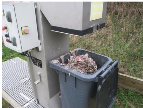
Récupération des déchets à l'entrée d'une station de traitement des eaux usées
