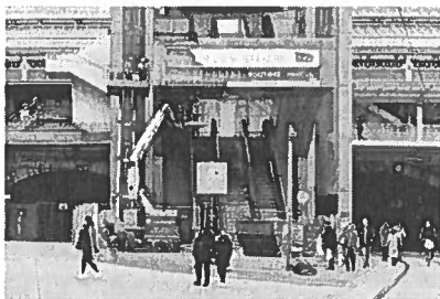
Ici, des travaux à l'entrée sud de la gare SNCF de Perrache, à Lyon. Photo Maxime Jegat
