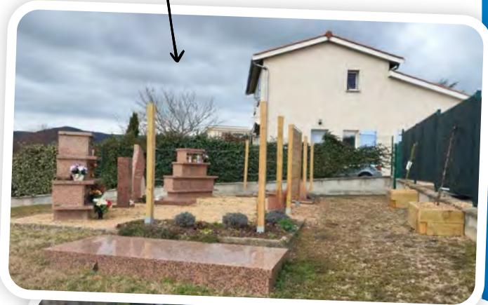
Rénovation du cimetière
