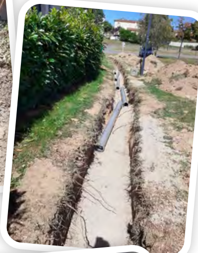
Charte des communes ECONomes : installation d'une cuve pour récupérer les eaux pluviales
