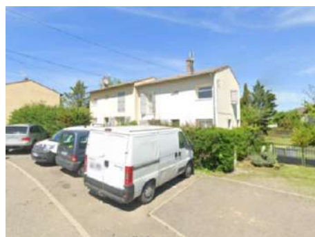
Chemin des Combattants - 16 logements
