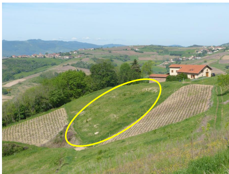
Illustration 9 : Glissement superficiel sur la commune d'Oingt dans les formations du Trias (photo BRGM)
