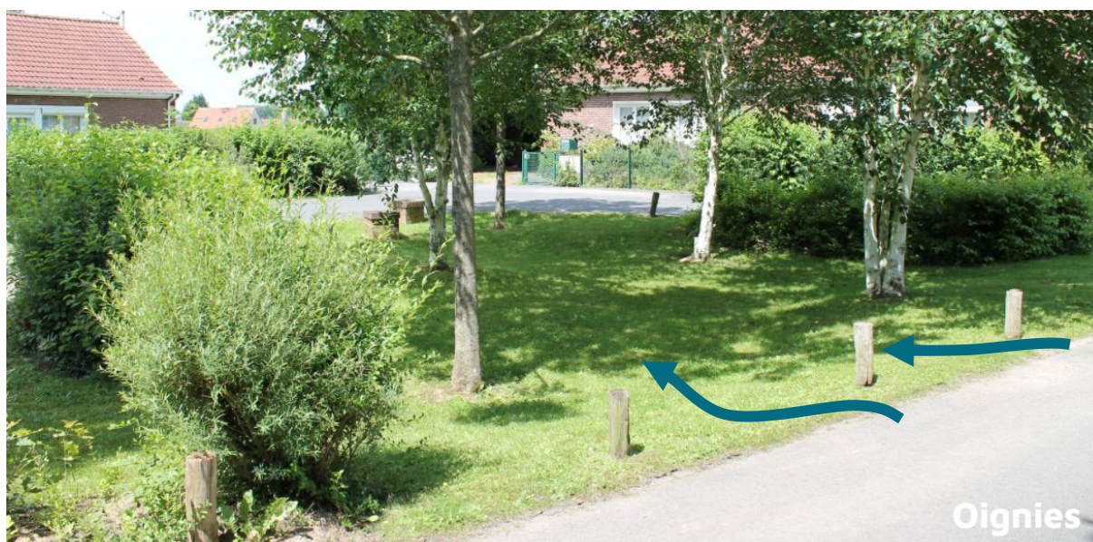
Figure 6 - Espace vert retravaillé en creux, pour gérer les eaux pluviales – Source ADOPTA
